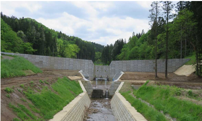
《高松岳の影響地域にある寺田川で、砂防えん堤や溪流保全工の整備》
