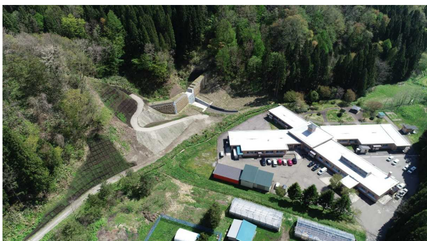
◀要配慮者利用施設を保全するため、砂防えん堤を施工した小坂町・八九郎東沢▶
